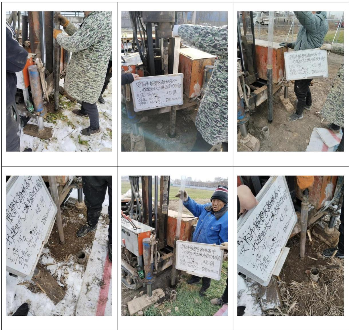
图 4-5 现场钻探采样
